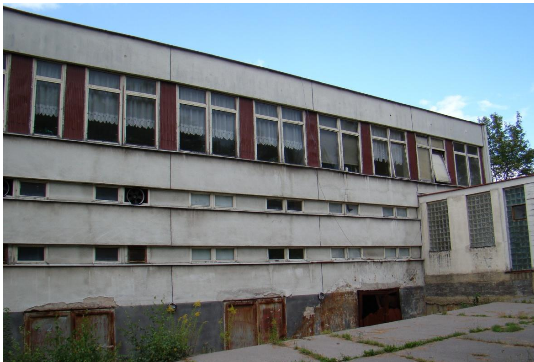
Jižní fasáda ZŠ Pelechovská Železný Brod (pavilon S2) – dole vrata uhelny, ve 3.NP jídelna a kuchyně
