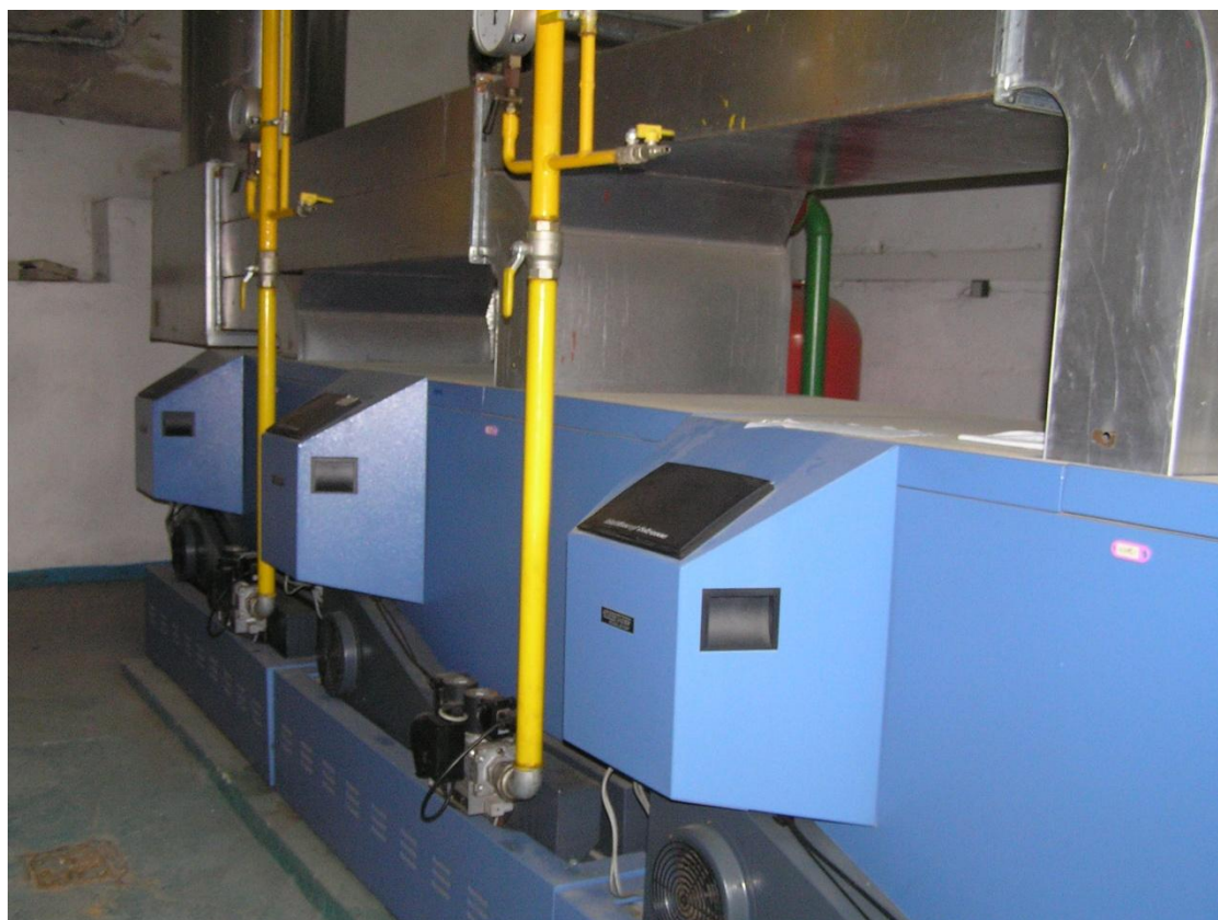
Stacionární plynové kotle s výkonem á 330 kW z roku 1996
