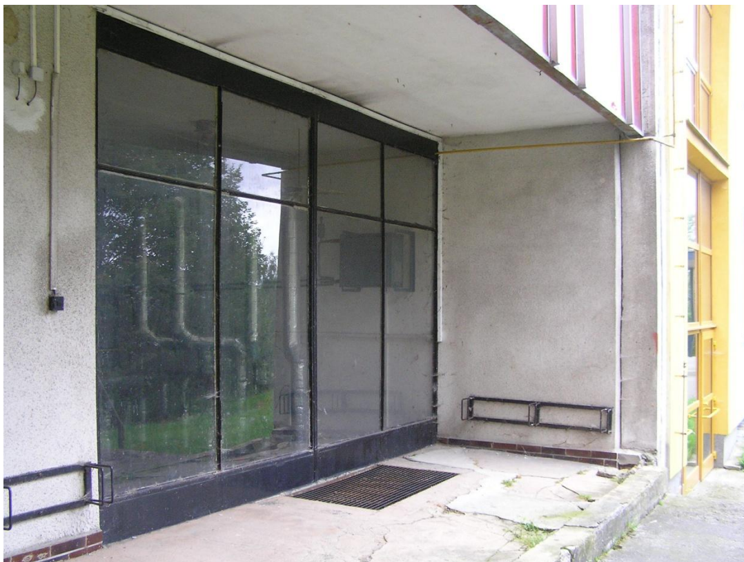
Pohled na kotelnu zvenku
