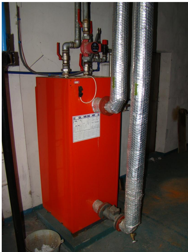
Nepřímotopný zásobníkový ohřivač TV pro potřeby pavilonu S2 (kuchyně)
