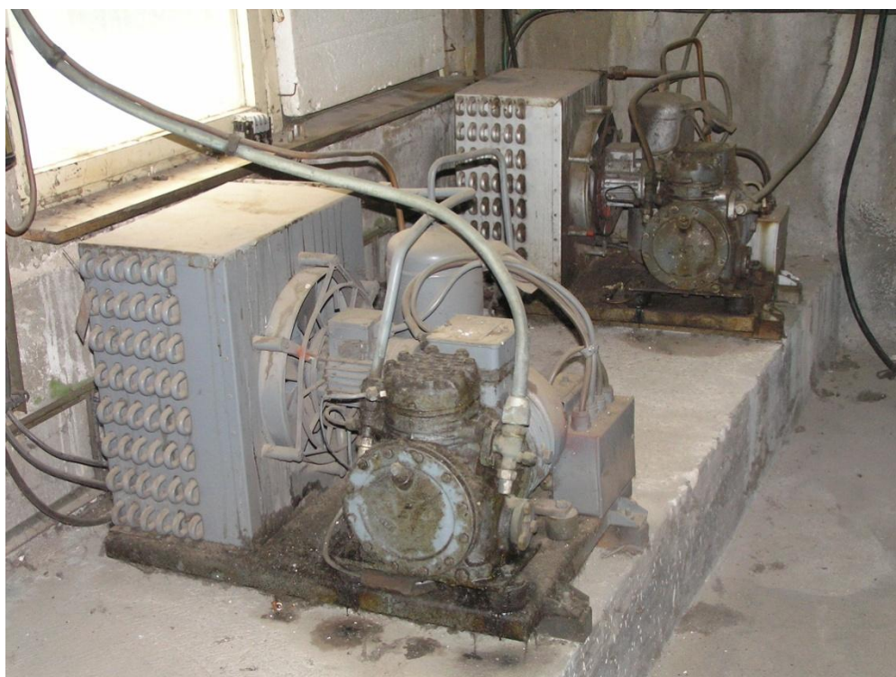
Kompresorové chlazení pro chladicí boxy sloužící ke skladování potravin, v současné době je v provozu pouze 1 kompresor s příkonem 1,25kW
