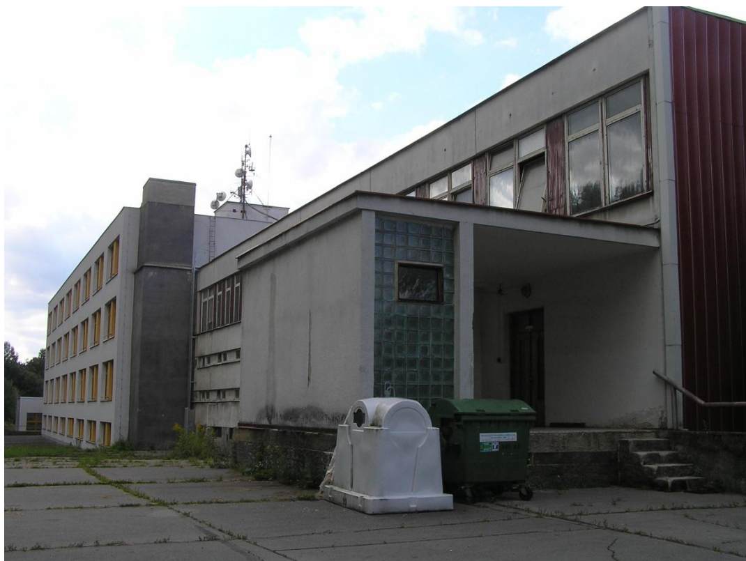
Jižní fasáda ZŠ Pelechovská Železný Brod (pavilon S2 a U12.2) – zásobování stravovacího pavilonu
