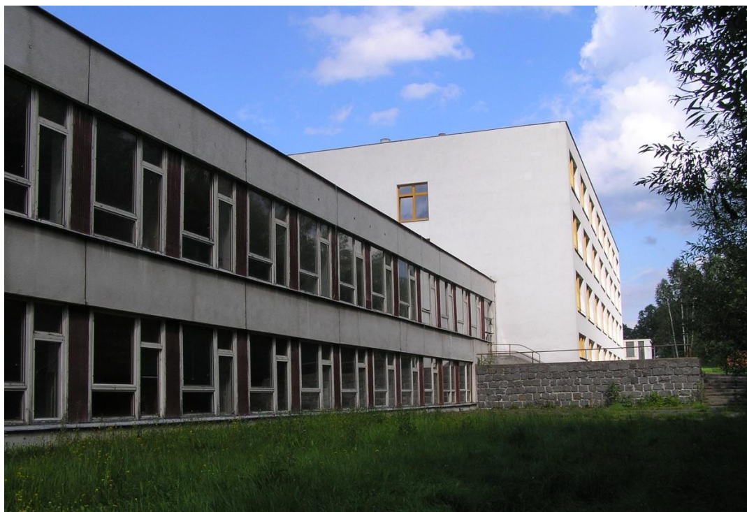
Jižní fasáda ZŠ Pelechovská Železný Brod (pavilon MVD2 a vzadu U12.2)
