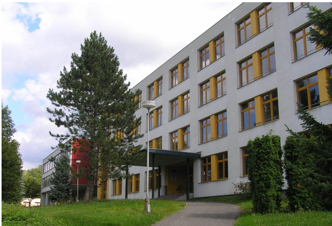
Severní vstupní fasáda ZŠ Pelechovská Železný Brod (pavilon U12.2 a vzadu S2)
