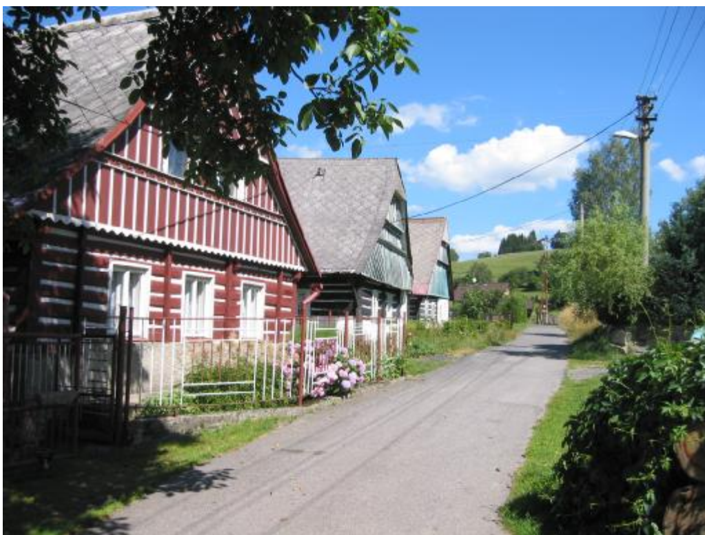
Původní zástavba při vjezdu do řešeného území od jihu (čp. 11, 31, 35 - nemovité kulturní památky)
