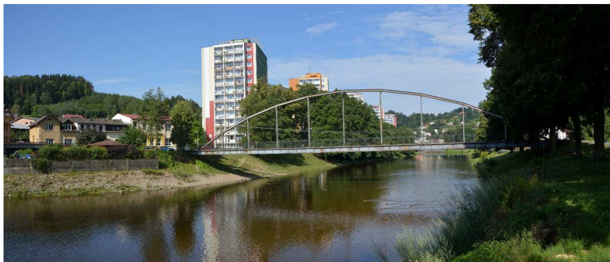
Obr. 1: Stávající oblouková lávka
