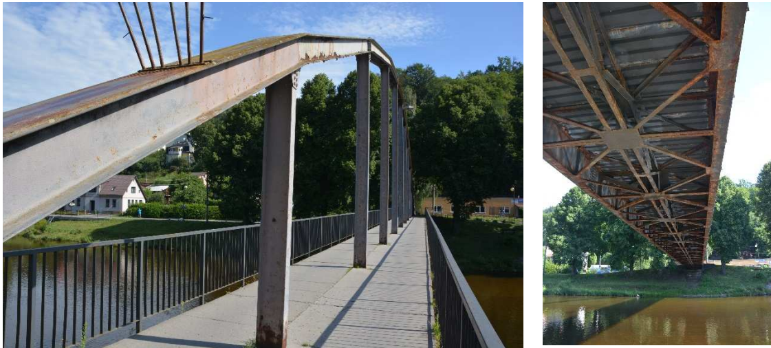
Obr. 2, 3: Stávající lávka je ve špatném stavu
