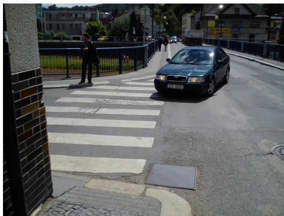
(FOTO 2) most přes Jizeru – úzké chodníky, nerovnosti povrchu na přilehlých přechodech
