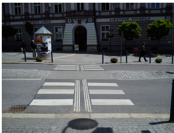
B2p Přechod na nám. 3. května proti vchodu do MěÚ (budova A) Bezbariérový s výhradou
