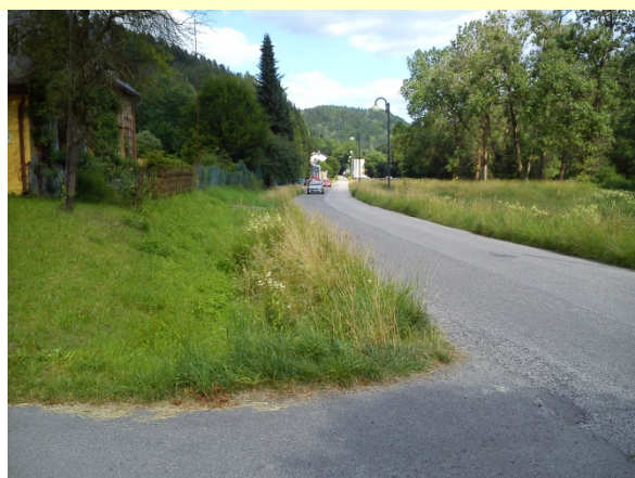
E11 Nábř. Obránců Míru (č.p. 570 – koupaliště) Bezbariérový s výhradou
