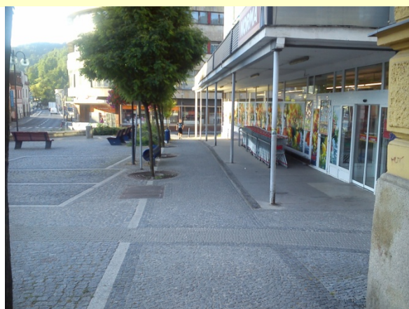
B9 Chodník po nám. 3. května podél objektu NORMA Bezbariérový s výhradou
