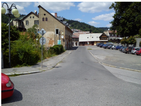
D9 Chodník na západní straně Malého nám. Bariérový
