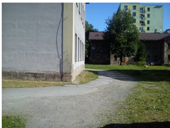
B17 Účelová komunikace napojující objekt zdravotního střediska ☹ Bezbariérová s výhradou
