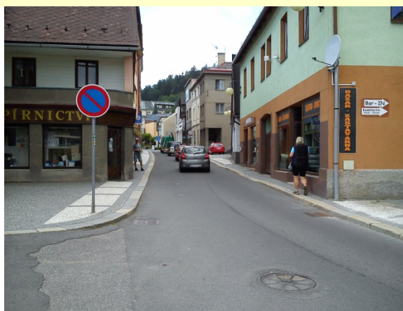
D4 Chodník na Husově ul. (nám. 3.května – Malé nám.) Bariérový
